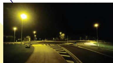
Eclairage d'un giratoire ComCom du Grand Chambord (Fontaines-en-Sologne 41)
