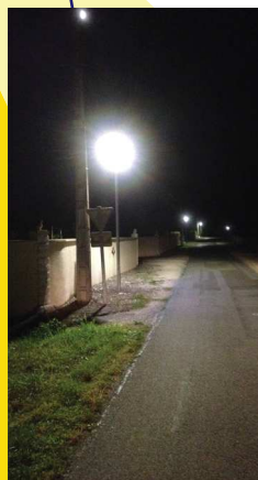
Rénovation éclairage (Noyers-sur-cher 41)
