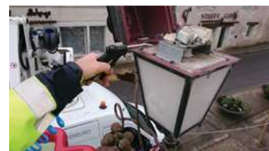
Rénovation du parc EP (Angé 41)
